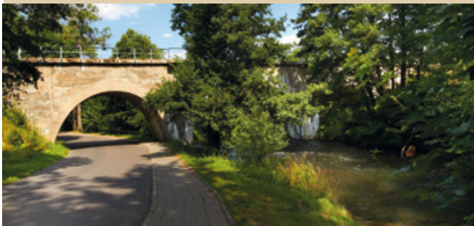
Most kolejowy nad szosą i rzeką Wdą
